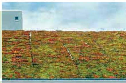
Fugen bei Vegetationsmatten
