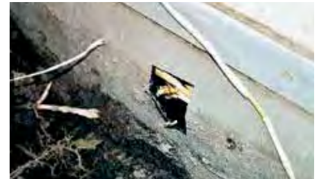
Bereits durch die Abdichtung gewachsene Bambusrhizome
