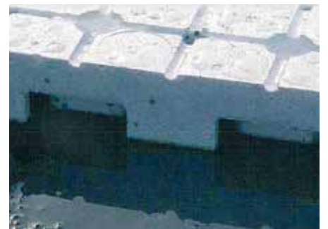
Die Lösung: ausreichend hohe Drainage mit Kapillarbruch.
