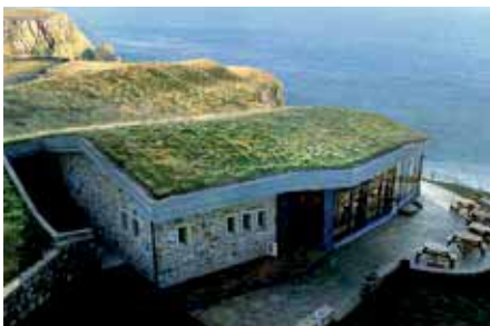
Exponiert stehende Gebäude müssen hinsichtlich des Windes kritisch betrachtet werden.
