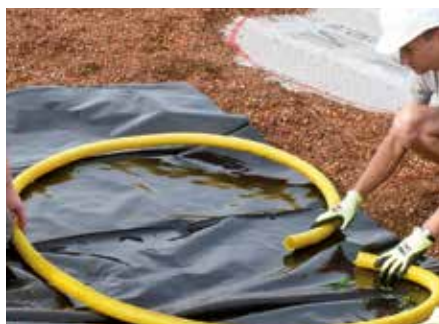
Mit Dränschläuchen und Folien entstehen temporäre Wasserflächen.
