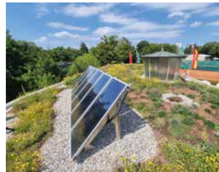
Die Dachbegrünung ließ sich auch mit der bestehenden Solaranlage kombinieren – das bringt sogar Synergieeffekte.
