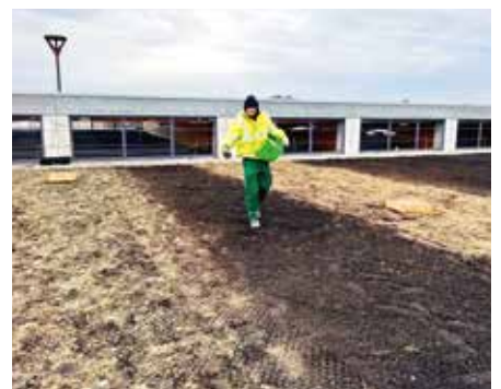
Auf abgegrenzten Bereichen wurden zertifiziertes gebietseigenes Saatgut und samenhaltiges Rechgut aus Sandtrockenrasen der Region ausgebracht.
