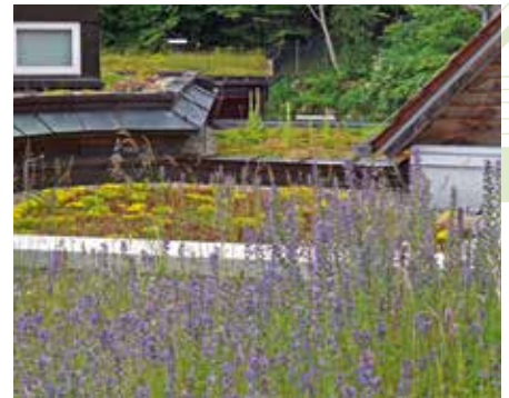
Nach den ersten beiden trockenen Jahren haben sich die Flächen im Deckungsgrad gut entwickelt.
