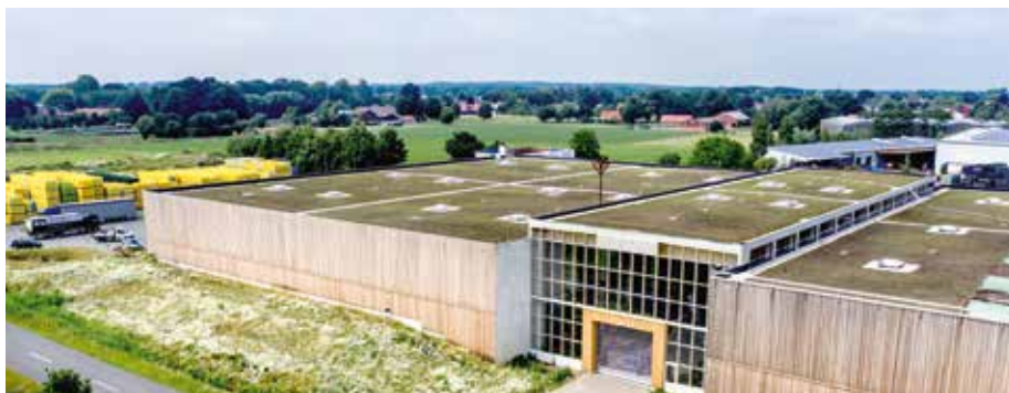
In Kooperation mit der Hochschule Osnabrück entstand die ca. 10.000 m 2 große Dachbegrünung mit regionaltypischer Biodiversität auf dem Hallendach der Firma Lütvogt.
