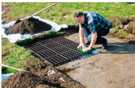
Das Fallnet® SR lässt sich auch in bereits bestehende Begrünungen nachträglich einbauen. Hier wird der Anschlagpunkt in das Rasterelement eingesteckt.
