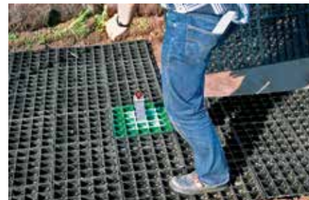
In Summe sind es vier vorgesteckte Elemente, die eine kraftverteilende Scheibe von ca. 5,3 m 2 ergeben.
