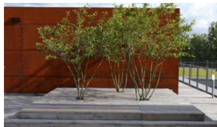
Die Sträucher ragen durch ein Podest, da bei Strauch- und Baumpflanzungen höhere Schütthöhen erforderlich sind.
