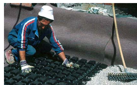
Verlegung der Dränelemente Floradrain® FD 60.
