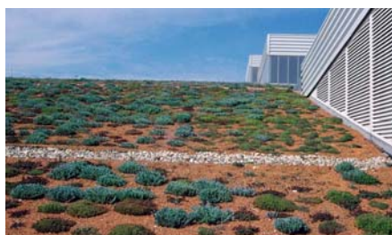
Unter den querlaufenden Kiesstreifen verbirgt sich die Dachentwässerung.
