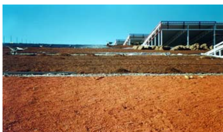
Das Zincolit® wurde auf der gesamten Dachfläche verteilt und darauf das Jute-Erosionsschutzgewebe gelegt.
