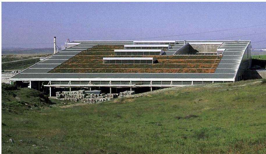
Durch die Dachbegrünung wurde die riesige Halle „Teil der Landschaft“.
