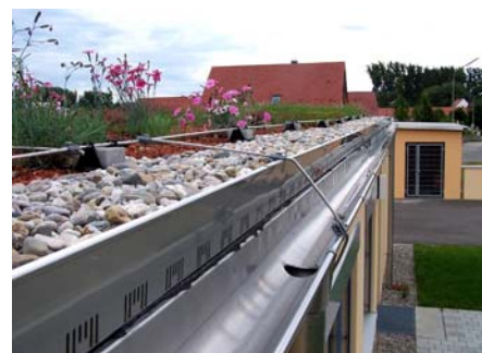
Die Dachbegrünung wurde mit 120 mm hohen Dachtraufprofilen aus Edelstahl eingefasst.
