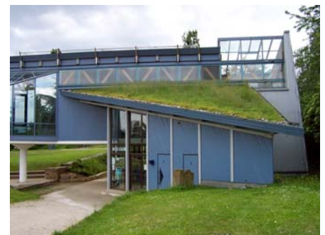
...während auf dem Nord-Dach auch zahlreiche Gräser zu finden sind.
