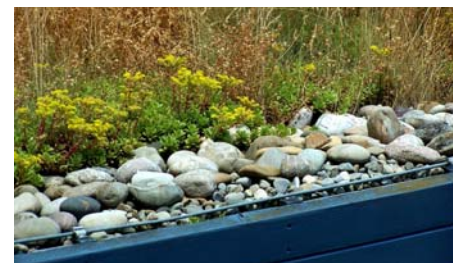
Der Dachrand mit dem schmalen Streifen aus Grobkiess.
