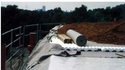
Vor Aufbringung der Systemerde.
