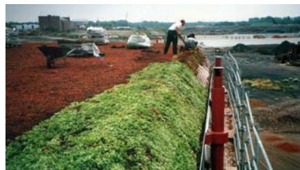
Verlegung der Sedum-Vegetationsmatten.
