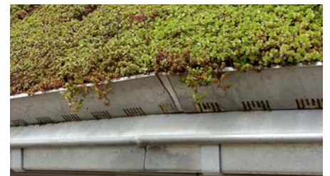
Entwässert wird durch das Dachtraufprofil DP 120-E in eine Regenrinne.
