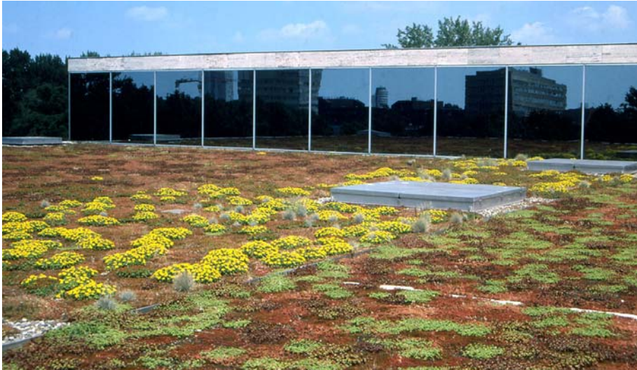
Zwischen rotblühenden Sedum-Arten wurde ein Streifen gelbblühender Arten gepflanzt.
