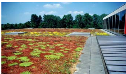
Ein pflegearmer Teppich aus niedrigwachsenden Sedum-Arten schützt und ziert das Dach des Hörsaalgebäudes.
