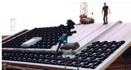
Auf der Wasserspeichermatte WSM 150 werden beginnend von unten die Georaster®-Elemente verlegt.
