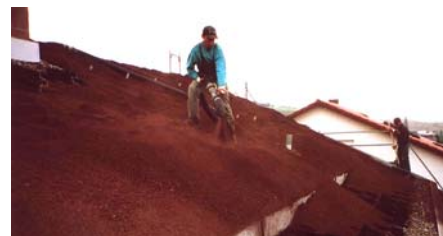
Die Systemerde „Lavendelheide“ wurde im Silozug angeliefert und aufs Dach „geblasen“.
