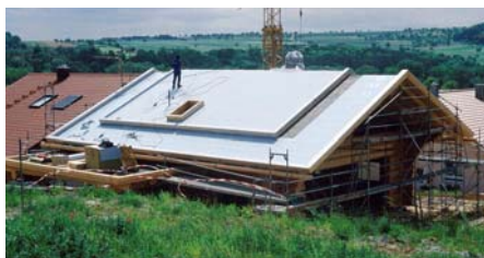
Die zu begrünende Dachfläche wird mit einer wurzelfesten Kunststoffbahn abgedichtet.
