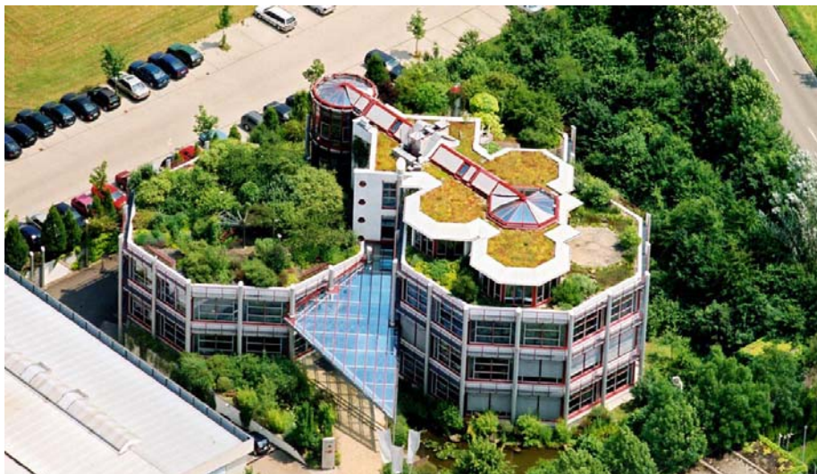
Das Gebäude mit seinen begrünten Dachebenen acht Jahre nach Fertigstellung.
