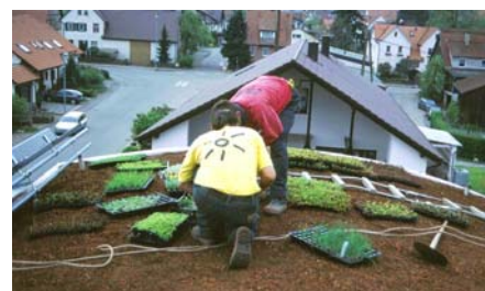
Die einzelnen Etappen der Dachbegrünungsarbeiten.
