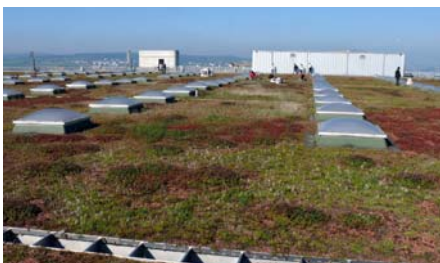
Das begrünte Dach während der Pflegearbeiten im September 2010.
