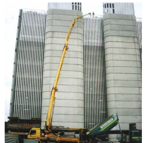
Aufblasen des Substrats mittels Spezial-LKW und mobiler Pumpe.
