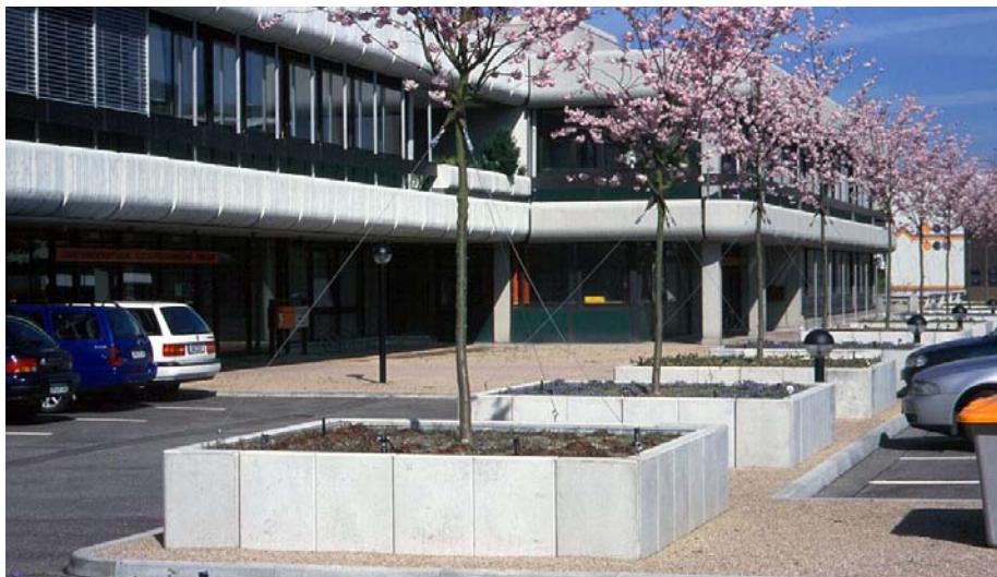
Fahrbahnen und Parkplätze wurden asphaltiert, Teilflächen mit Zierkies belegt.
