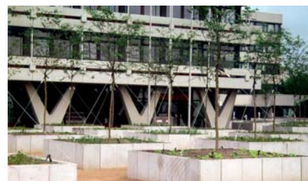
Die Baumquartiere wurden aus L-Steinen gebildet, an denen auch die Baumstämme befestigt wurden.
