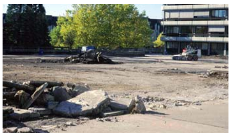
Zunächst musste der alte Schutzbeton entfernt werden.
