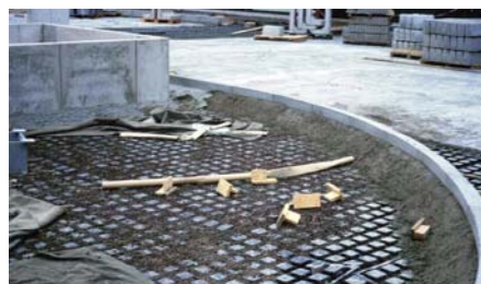
Floradrain® FD 60 Elemente bilden den Untergrund für Baumquartiere und für Geh- und Fahrbeläge.
