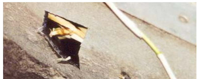
durch Abdichtung gewachsene Bambusrhizome
