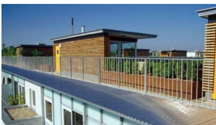
Die Gelander aus verzinktem Stahl gewahren die Sicherheit der Anwohner.
