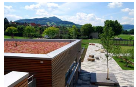
Blick auf das Dach und auf die umliegende grüne Landschaft mit der Burg Teck im Hintergrund.
