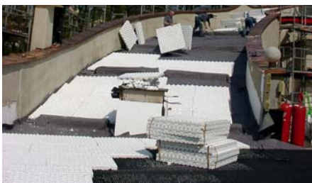
Verlegung von Floraset® FS 75-Elementen in den bis ca. 20° geneigten Dachbereichen.
