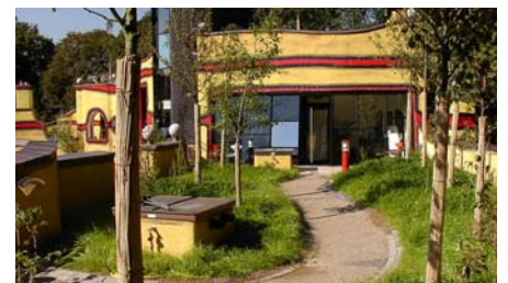
Im Flachdachbereich schlängelt sich ein Fußweg durch eine kleine Allee.
