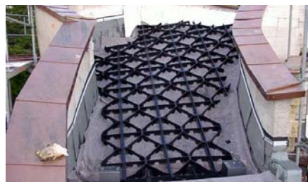
Georaster®-Elemente dienen zur Aufnahme und Ableitung des Erdschubs bei Neigungen zwischen 20° und 35°.
