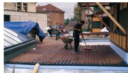
Die Dachkonstruktion wurde als Umkehrdach ausgeführt. Hier sieht man die Verlegung der Floradrain® FD 60- Elemente.
