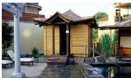
Natursteinplatten und Zierkies bilden die Belagsfläche rings um das Heißwasserbecken.
