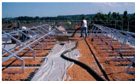
Das Dachbegrünungssubstrat wird mittels Silozug pneumatisch auf das Dach befördert.
