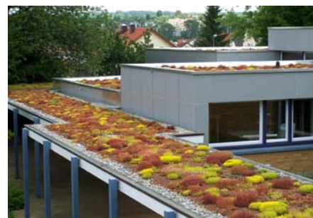
Weitere begrünte Dachflächen der Grund- und Hauptschule in Unterensingen.
