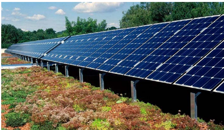
Die Anlage im Juli 2003 – der „Sedumteppich“ beginnt sich zu schließen.
