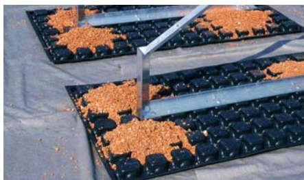
Die Tragrahmen der Solaranlage wurden jeweils auf einer 2 m 2 großen ZinCo Solarbasis® SB 200 montiert.
