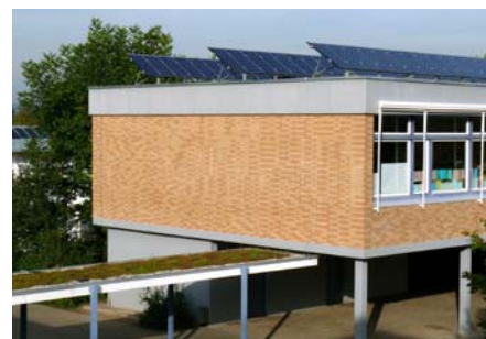
Teil des Schulgebäudes mit der Solaranlage auf dem Dach.
