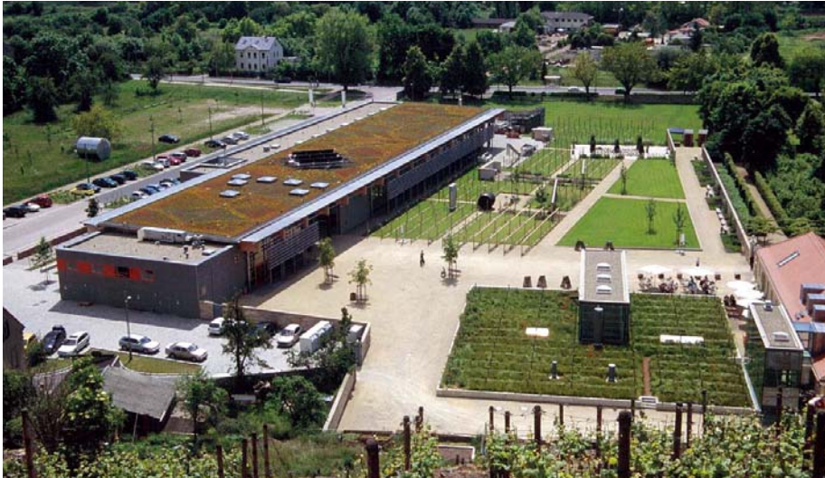
Die neue Produktionsanlage und das Hochbeet mit Weinfeld des Sächs. Staatsweingut Schloss Wackerbarth – vom Hang aus gesehen.
