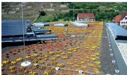
Auf dem Flachdach der Produktionshalle wurde eine extensive Dachbegrünung des Typs „Sedumteppich“ aufgebracht.
