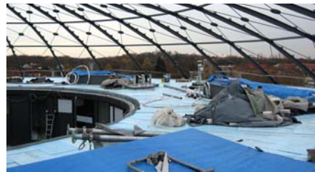
Die Dächer der Einfamilienhäuser wurden als Umkehrdach ausgebildet.
