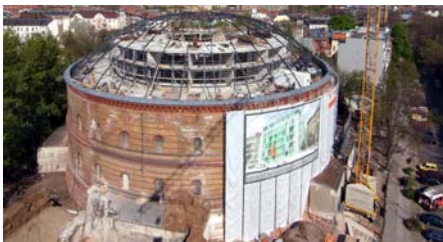
Auf dem ehem. Gasometer wurden 13 tortenförmige Einfamilienhäuser gebaut.
