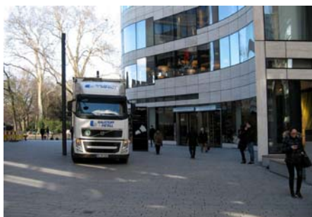
Da Fahrzeuge wie Lieferverkehr und Feuerwehr den Vorplatz passieren, war der Belagsaufbau auf diese Belastung auszulegen.
