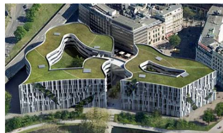
Auf der rund 4.000 m 2 großen extensiv zu begründenden Dachfläche wurde Floraset® FS 50 verbaut. Diese Elemente eignen sich insbesondere für große Dachflächen mit geringstem Gefälle und langen Entwässerungsstrecken.
