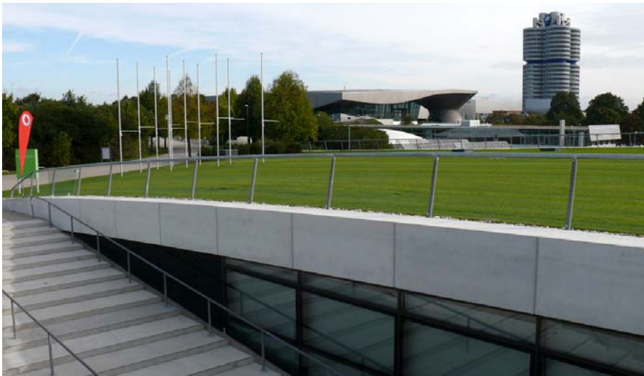
Die Kleine Olympiahalle wurde unterirdisch in die Landschaft des Parks eingebettet.
