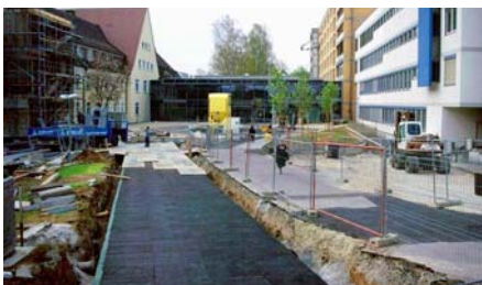
Verlegung von Elastodrain® EL 202 unter der späteren Krankenhaus-Zufahrt.
