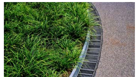
Zwischen Pflanzbeet und Fahrbelag wurden speziell angefertigte Rinnen eingebaut.
