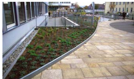
Auf der Substratoberfläche sind die Tröpfschläuche der Bewässerungsanlage zu erkennen.
