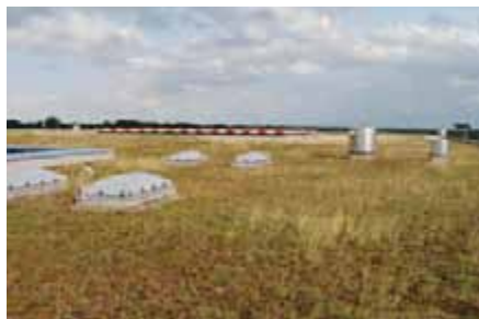
Ein klassischer Extensiv-Dachbegrünungsaufbau (Typ „Sedunteppich“) verdunstet in sommerlicher Trockenheit 20–50 l/d .
