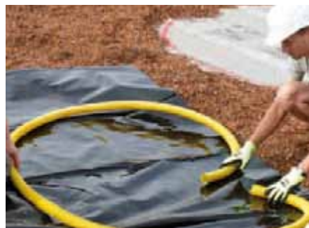
Mit Dränschläuchen und Folien entstehen temporäre Wasserflächen.
