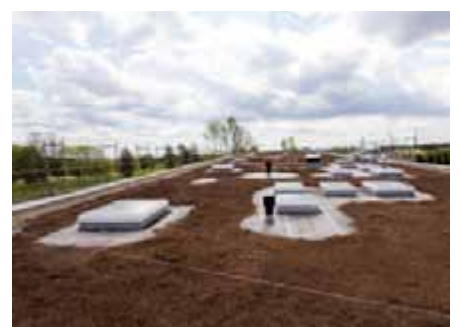
Die fertig eingebaute Systemerde Steinrosenflur.
