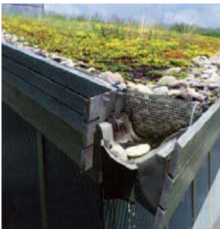
Abflussverzögerung einer extensiven Dachbegrünung
