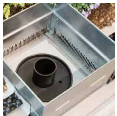
... bis ca. 80 l/m 2 temporärer Wasseranstau im Retentionsraum unterhalb einer Dachbegrünung
