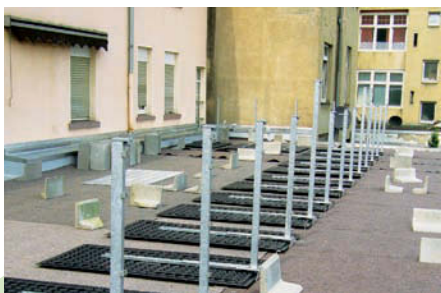
Nach Aufbringen einer Schutzlage über der Dachabdichtung werden die Geländerbasen GB/GB-Eck ausgerichtet und die Pfosten sowie ggf. die Halter für die Anschlagschiene montiert.
