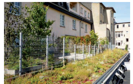
Nach dem abschließenden Montieren von Fallnet® SB 200-Rail steht den gesicherten Arbeiten im Bereich des Dachrandes nichts mehr im Wege.
