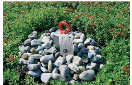
Jedes Fallnet® SR wird mit einer Kennzeichnungsplakette am Anschlagpunkt ausgeliefert. Auf dieser finden Sie die Produktbezeichnung, die Prüfnorm, das Herstellungsdatum und die Seriennummer. Somit ist für den Nutzer auf den ersten Blick ersichtlich, dass es sich um eine Anschlagseinrichtung zur Absturzsicherung handelt.
