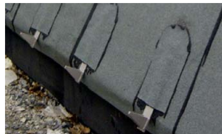
... an den unteren Dachrändern Traufschubhalter des Typs TSH 100 montiert und eingedichtet, welche zur Abtragung der Schubkräfte dienen.
