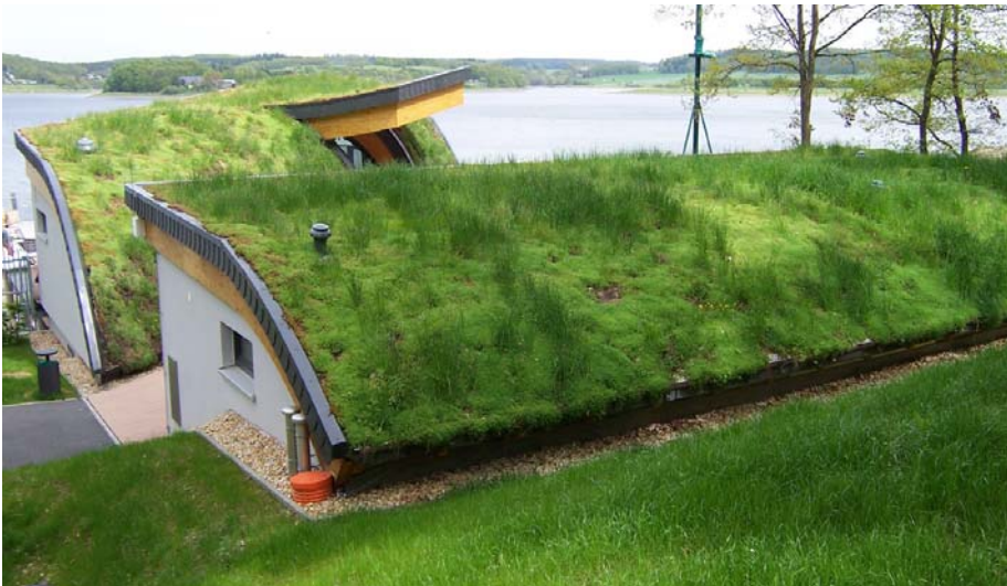
Die Schiffsanlegestelle an der Talsperre Pöhl mit Kassen- und Informationshäuschen und kleinem Bistro liegt direkt am Weg zwischen dem Campingplatz Gunzenberg und der Staumauer.
