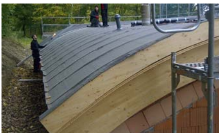
Nachdem das Dach wurzelfest abgedichtet war, wurden vor Aufbringen der Schichten des Gründach-Systemaufbaus ...
