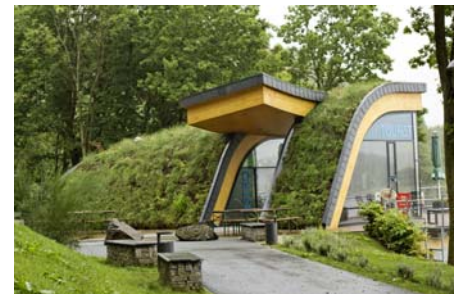
Die zwei Gebäude mit insgesamt rund 270 m 2 Dachbegrünung integrieren sich perfekt in die Landschaft.
