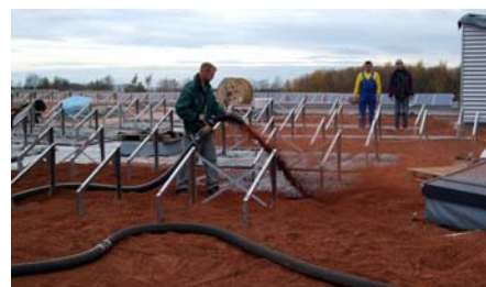
Das Dachbegrünungssubstrat wurde mittels Silozug pneumatisch auf das Dach befördert.
