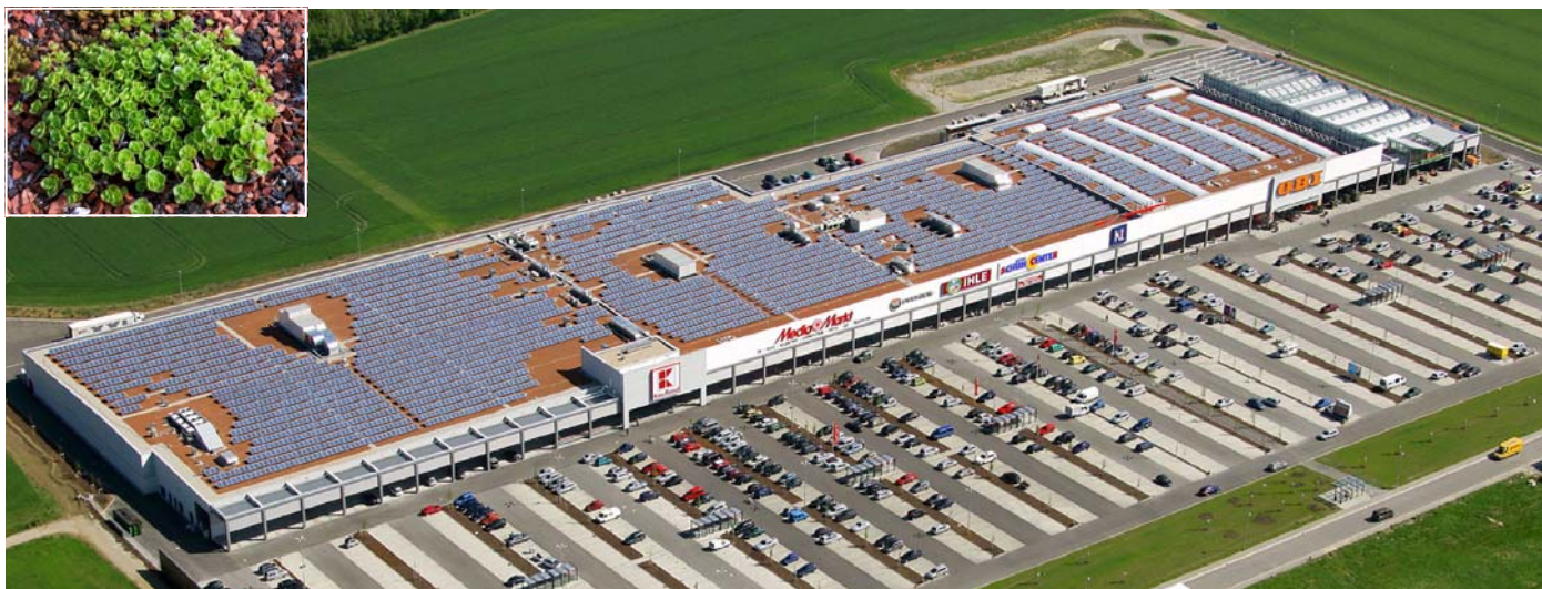
Eine Kombination mit vielen Synergieeffekten: Dachbegrünung und Photovoltaik auf dem InCenter in Landsberg am Lech.
