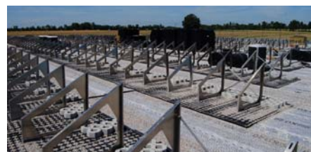
Auf die vlieskaschierte Schutz-, Drainage- und Wasserspeicherbahn Fixodrain ® XD 20 wurden die Solarbasisplatten SB 200 auf Stoß verlegt und anschließend mit den Solargrundrahmen bestückt.
