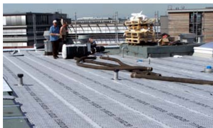
Die Pfosten der Abgrenzung des Wartungs- und Fluchtweges wurden ohne Durchdringung der Dachhaut auf der ZinCo Geländerbasis montiert. In Splitt verlegte Betonplatten dienen als Auflast. Unter den begrünter Dachflächen kamen Schutz- und Drainagebahnen des Typs Fixodrain® XD 20 zum Einsatz.
