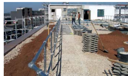
Die Pfosten der Abgrenzung des Wartungs- und Fluchtweges wurden ohne Durchdringung der Dachhaut auf der ZinCo Geländerbasis montiert. In Splitt verlegte Betonplatten dienen als Auflast. Unter den begrünter Dachflächen kamen Schutz- und Drainagebahnen des Typs Fixodrain® XD 20 zum Einsatz.
