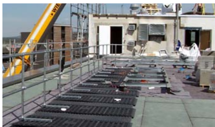
Die Pfosten der Abgrenzung des Wartungs- und Fluchtweges wurden ohne Durchdringung der Dachhaut auf der ZinCo Geländerbasis montiert. In Splitt verlegte Betonplatten dienen als Auflast. Unter den begrünter Dachflächen kamen Schutz- und Drainagebahnen des Typs Fixodrain® XD 20 zum Einsatz.
