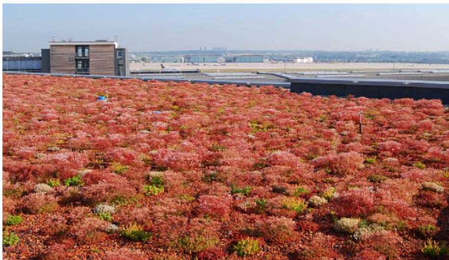
Bereits nach der ersten Vegetationsperiode zeigt sich die Vegetation auf dem Verwaltungsgebäude am Stuttgarter Flughafen geschlossen und in voller Blüte.
