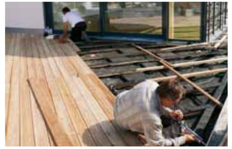
Dieser Belag steigt vom „Zwangspunkt Türaustritt“ bis zur Dachkante hin stetig an, so konnte Höhe für den Begrünungsaufbau gewonnen werden.
