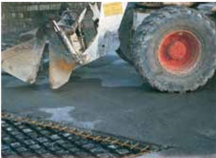
Auf Schottertragschichten (siehe vorige Seiten) bzw. auf der druckverteilenden Betontragplatte auf Floradrain® FD 60 ist der Einbau von Asphalttragschichten
