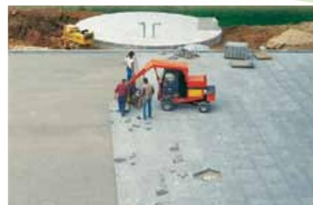
Der „Vor-Kopf-Einbau“ der Tragschicht und von den darüber liegenden Schichten ist auf Elastodrain® EL 202 sogar mit schwerstem Gerät möglich.
