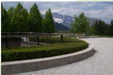
Randbefassungen, die auf dem Drän-element betoniert werden, gewährleisten eine sichere Abgrenzung.
