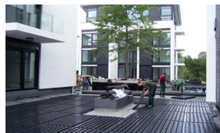
Die Verlegung der Floradrain® FD 60-Platten erfolgt lose mit ca. 3-4 cm Überdeckung der Ränder. Um das Dränelement belastbar zu machen, wird es mit Zincolit® Plus verfüllt.
