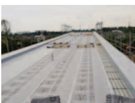
Grundlage ist ein Systemaufbau "Steinrosenflur", hier das Drainage-Element Fixodrain® XD 20.
