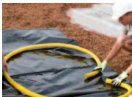
Mit Dränschläuchen und Folien entstehen temporäre Wasserflächen.
