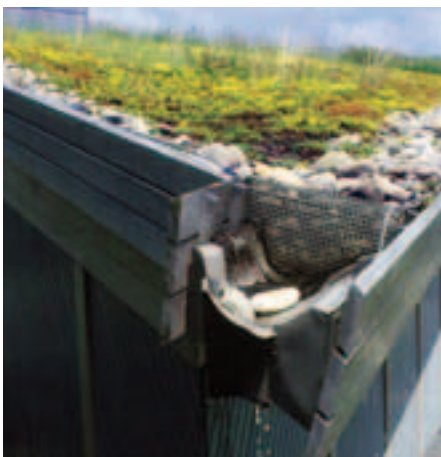
Abflussverzögerung einer extensiven Dachbegrünung.
