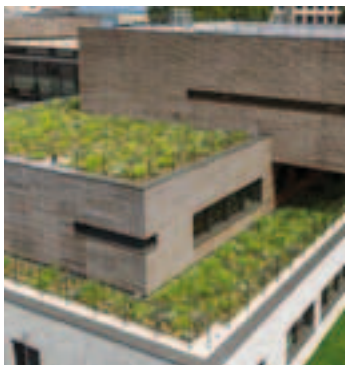
Systemaufbau „Bewässerte Extensivbegrünung“ 12
