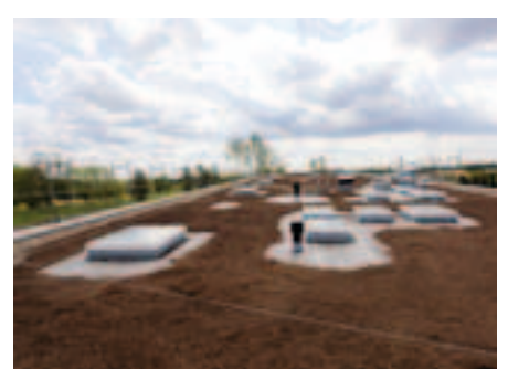
Die fertig eingebaute Systemerde "Steinrosenflur".
