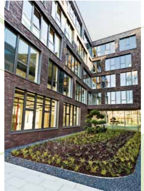
Retentionsflächen auf einem, als Innenhof angelegten, Tiefgaragendach in Ratingen.
