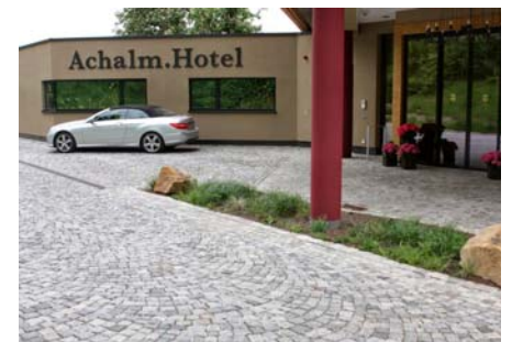
Vor dem Hoteleingang und der Zufahrt kam ein Belag aus Granitpflaster – und zwar aus gebrauchten Natursteinen – zum Einsatz.
