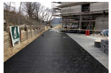
Im Zufahrtsbereich wurde Elastodrain® EL 202 vollflächig verlegt und mit passenden Verbindern fixiert.
