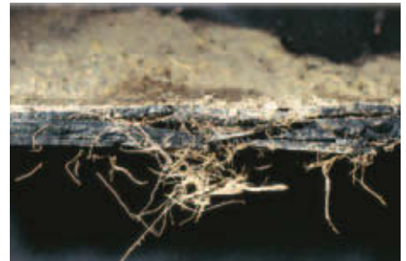
Eine von Wurzeln durchdrungene Bitumenabdichtung ohne Wurzelschutzausrüstung.
