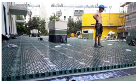
In den Hohlräumen der vollflächig verlegten RSX 80-Elemente können mehr als 70 l/m 2 Regenwasser zwischengespeichert werden.
