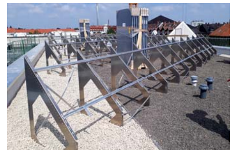
Die Unterkonstruktion der Solarthermie-Kollektoren wird ohne Dachdurchdringung nur durch Auflast gehalten.
