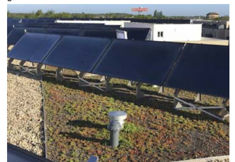
Die Solarthermie-Anlage funktioniert bereits, während die Sedum-Arten der Extensivbegrünung noch Entwicklungszeit benötigen.
