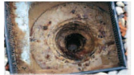
Schutzschichten aus Beton bergen das Risiko der Versinterung der Dachabläufe. Mit Schutzlagen aus Synthesefasern oder Kautschuk kann dies verhindert werden.
