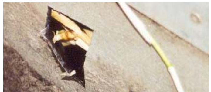
durch Abdichtung gewachsene Bambusrhizome
