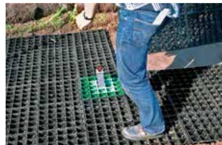
In Summe sind es vier vorgesteckte Elemente, die eine kraftverteilende Scheibe von ca. 5,3 m<sup>2</sup> ergeben.
