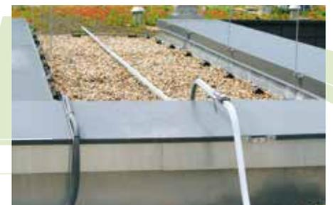
Durch ein S-förmiges Schienelement kann ein Höhenversprung elegant bewältigt werden, da der Läufer ohne Unterbrechung weiter gleiten kann.
