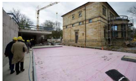
Auf der Umkehr-Wärmedämmung wird zunächst das extrem stabile, luft- und dampfdurchlässige Systemfiltervlies „PV“ eingebaut. Das bereits vlieskaschierte Fixodrive® FX 50 wird darüber ausgerollt. Auf der Schottertragschicht kann dann der Pflasterbelag in die Bettung gelegt werden.
