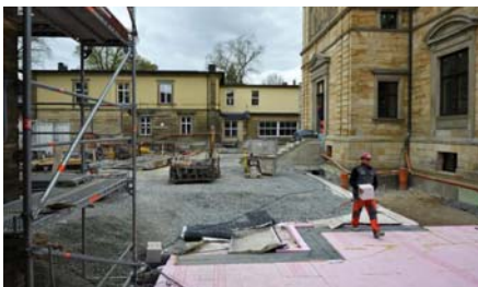
Auf der Umkehr-Wärmedämmung wird zunächst das extrem stabile, luft- und dampfdurchlässige Systemfiltervlies „PV“ eingebaut. Das bereits vlieskaschierte Fixodrive® FX 50 wird darüber ausgerollt. Auf der Schottertragschicht kann dann der Pflasterbelag in die Bettung gelegt werden.
