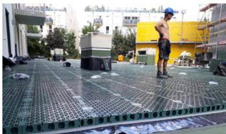
In den Hohlräumen der vollflächig verlegten RSX 80-Elemente können mehr als 70 l/m<sup>2</sup> Regenwasser zwischengespeichert werden.
