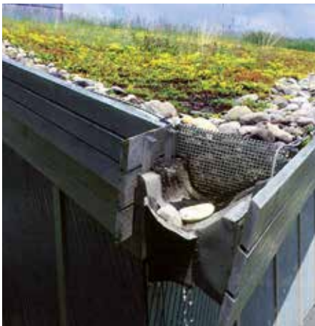
Abflussverzögerung einer extensiven Dachbegrünung.
