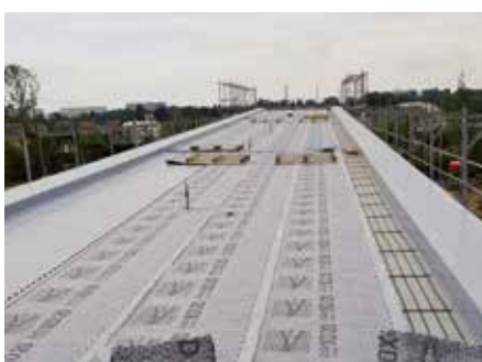
Grundlage ist ein Systemaufbau "Steinrosenflur", hier das Drainage-Element Fixodrain® XD 20.
