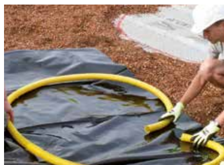
Mit Dränschläuchen und Folien entstehen temporäre Wasserflächen.
