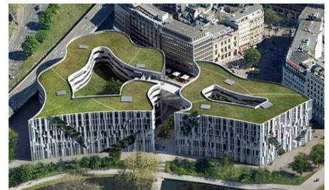
Auf der rund 4.000 m<sup>2</sup> großen extensiv zu begrünenden Dachfläche wurde Floraset® FS 50 verbaut. Diese Elemente eignen sich insbesondere für große Dachflächen mit geringstem Gefälle und langen Entwässerungsstrecken.
