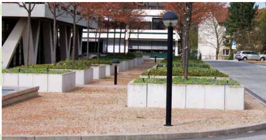
Sowohl unter den Pflanztrögen als auch unter den Fahrbelägen wurde eine durchgängige Drainage mit Floradrain® FD 60 realisiert.
