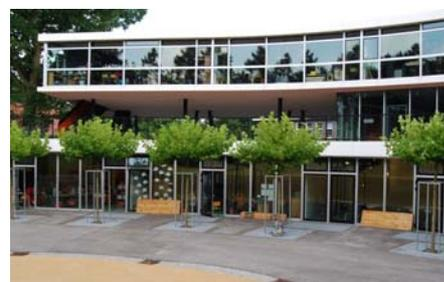
Über den Klassenräumen im Erdgeschoss befindet sich die Laufbahn, deshalb musste man besonders auf die Trittschalldämmung achten.
