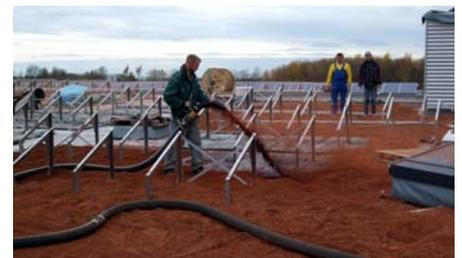
Das Dachbegrünungssubstrat wurde mittels Silozug pneumatisch auf das Dach befördert.
