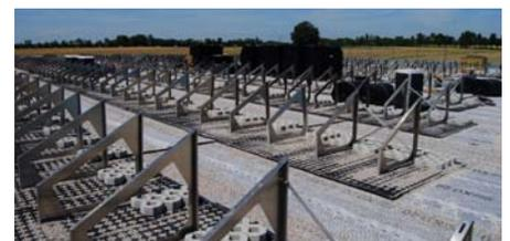
Auf die vlieskaschierte Schutz-, Drainage- und Wasserspeicherbahn Fixodrain<sup>®</sup> XD 20 wurden die Solarbasisplatten SB 200 auf Stoß verlegt und anschließend mit den Solargrundrahmen bestückt.
