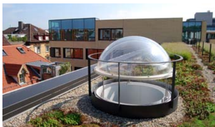
Um die Lichtkuppeln herum wurde der Bewuchs bewusst niedrig gehalten.
