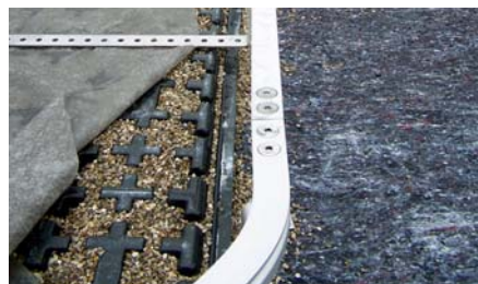
Zusätzlich wurde an den SB 200-Platten ein Schienensystem zur Sicherung gegen Absturz befestigt.
