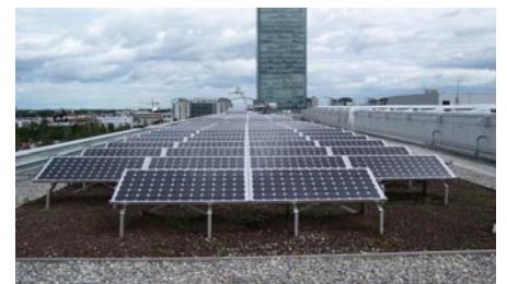
Die Solarpanels wurden bis fast an den Dachrand gebaut um die gesamte Fläche bestmöglich auszunutzen.
