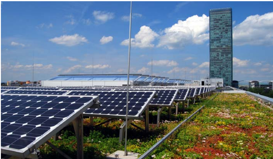
Solaranlage in Verbindung mit dem Sicherheitssystem Fallnet® Rail.
